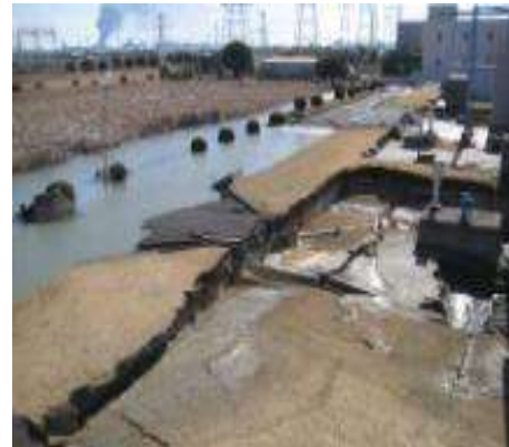
液状化により壊滅した浄水場
