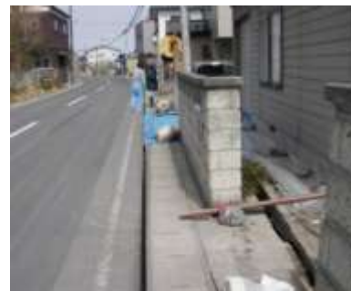
被害例2： 地震により旧鉱物採掘区域が崩落し、宅地に深さ約35cmの陥没が発生
