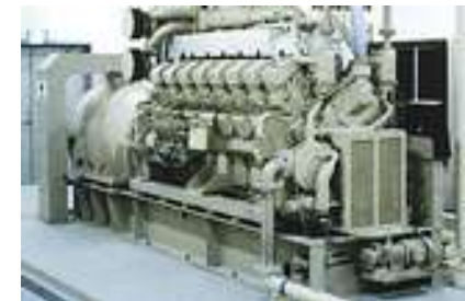
1,000KWクラス ディーゼルエンジン発電設備
