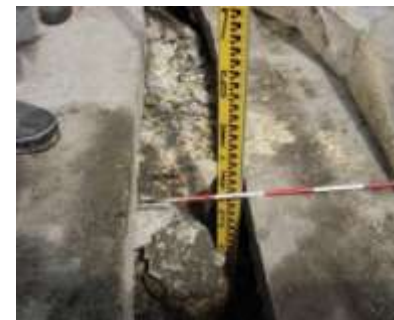
被害例2： 地震により旧鉱物採掘区域が崩落し、宅地に深さ約35cmの陥没が発生
