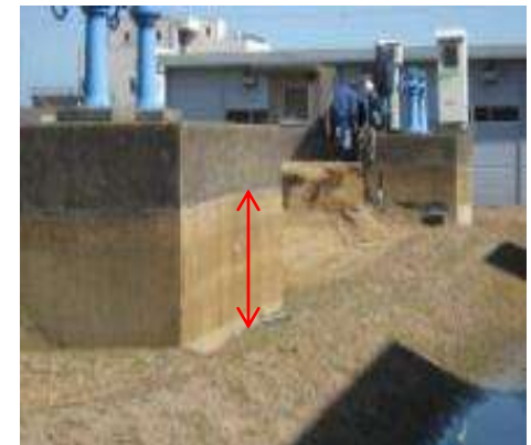
液状化により壊滅した浄水場
